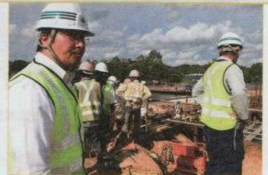
南部高速道路の建設も日本のODAで行われた
